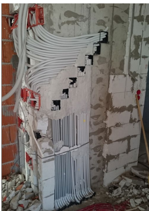
Cablare în formație "stea"
